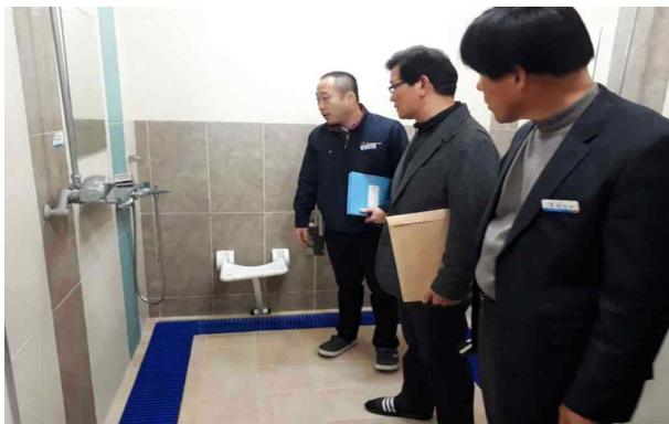
시민회관 수영장 장애인 시설 점검
